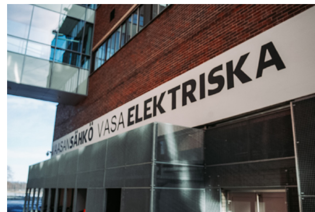
I dag är cirka 69 procent av lågspänningsnätverket och 38 procent av stamnätet mellan-spänningsnätet av bolagets totala elnät på 7 000 kilometer nergrävt.
