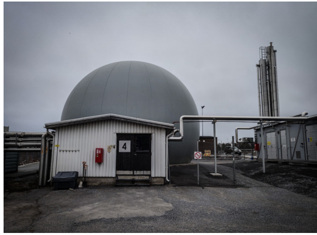
Naturgaserna förvaras i en rund förvaringstank för att hålla trycket.
